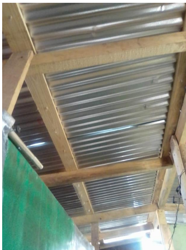
Levantamiento y donación de Zinc con colaboración de inavi.
